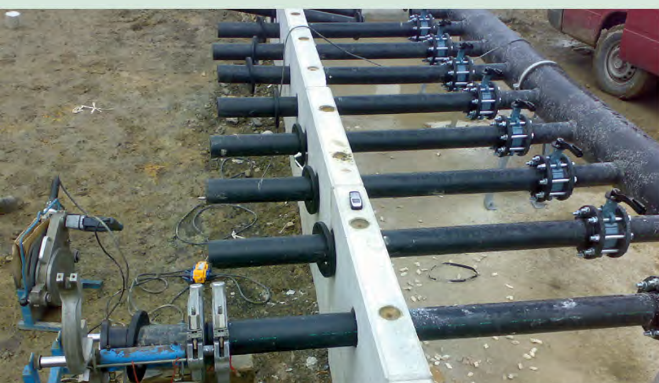
Deponiegas-sammelstation
