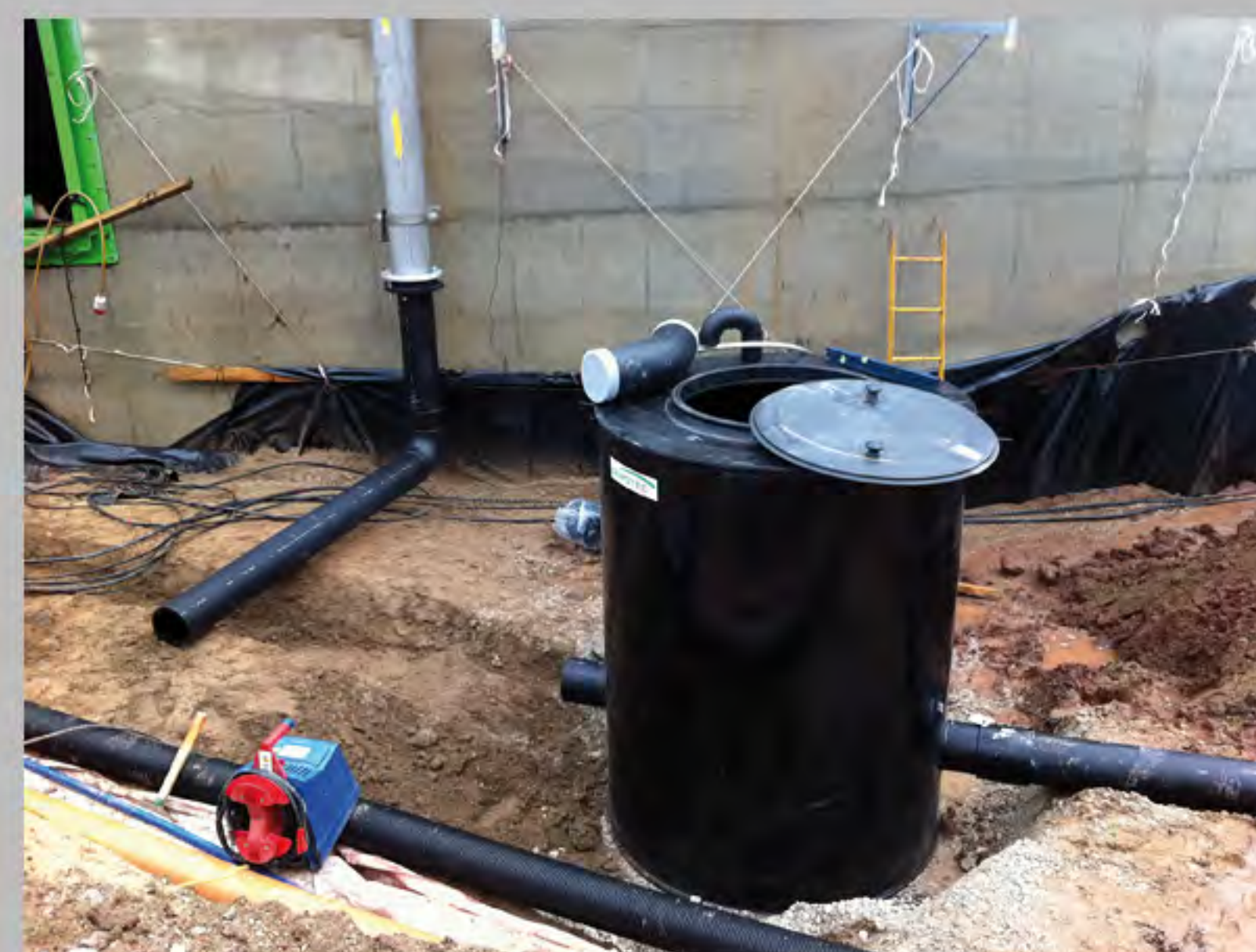
Kondensatschacht Biogasanlage
